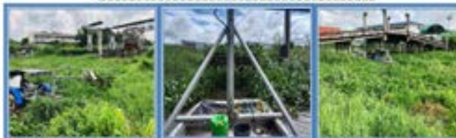
ระหว่างดำเนินการ กม.ที่ ๑๕.๕๐๐-๑๖.๕๐๐
