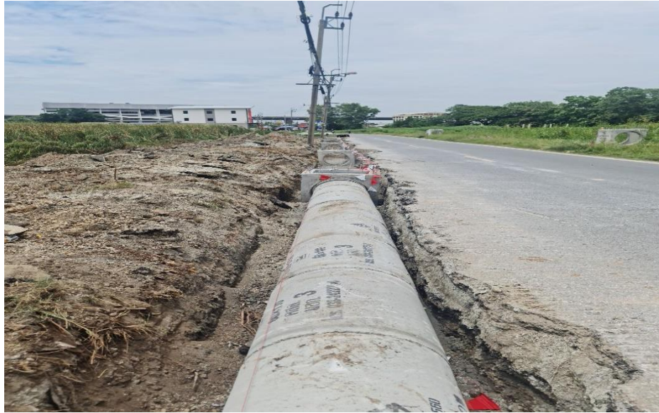
ภาพถ่าย ขณะดำเนินการวางท่อ
