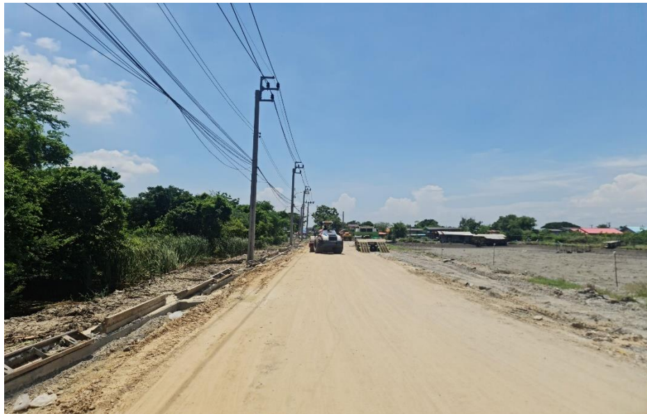
ภาพถ่าย ขณะบดอัดแน่น
