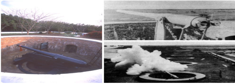
ภาพที่ 1.1-2 ป้อมแปลงไฟฟ้า
